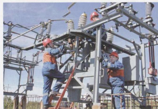
Ремонт масляного выключателя 35кВ на подстанции «17В» бригадой электрослесарей Возейского РЭС
